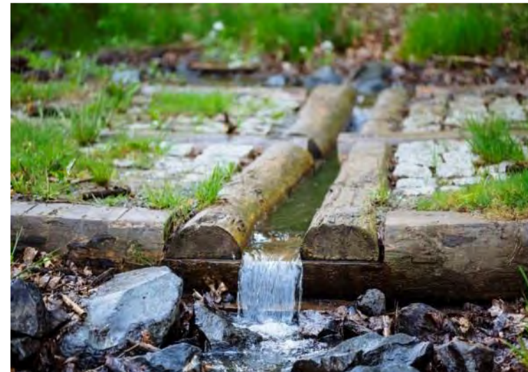
Przelew na małą wodę w środkowej części brodu.
